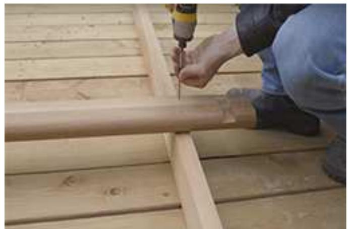
Une fois dans la position correcte, fixez la douille centrale au support avant à l'aide de vis de 2 ½ po.
