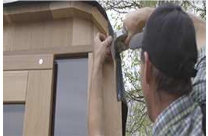
À l'aide de l'agrafeuse, fixez la membrane en caoutchouc à l'avant du sauna, comme indiqué.
