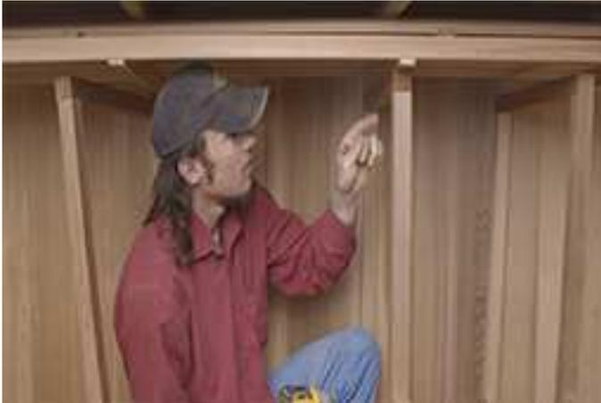
Pour installer les bancs intérieurs, alignez les supports sur les supports de banc sur les bancs supérieurs et inférieurs.
