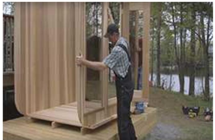
Avec 2 personnes, glissez le mur avant dans les bâtons inférieurs de la même manière que le mur arrière.
