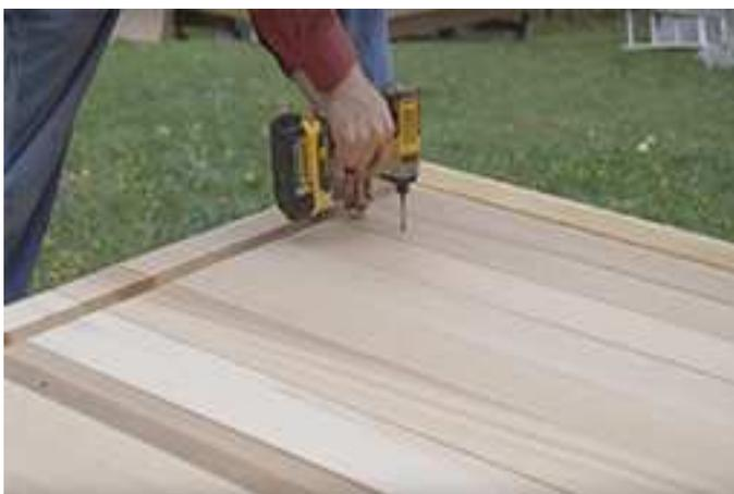
Une fois dans la bonne position, fixez les portées inférieures au support avant à l'aide de vis de 2  $\frac{1}{2}$  po.
