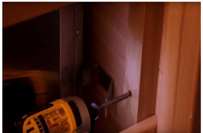
Utiliser des vis de 2 1/2 "dans les trous pré-perçés, attacher la garde au mur arrière.
