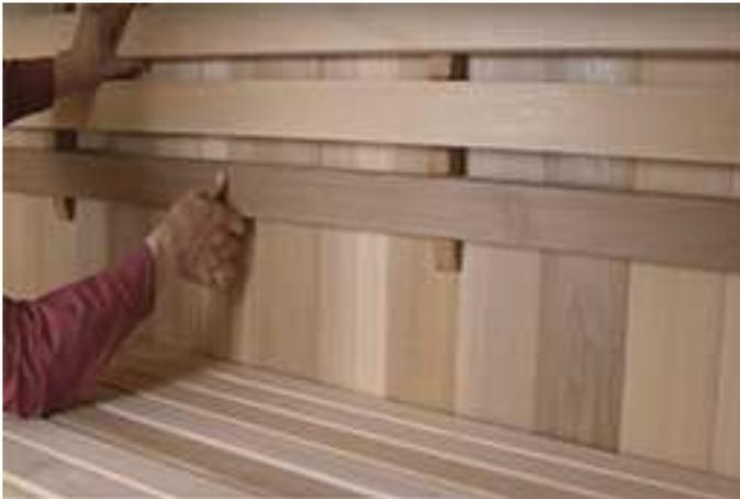
Positionner le support arrière à la hauteur désirée. Fixer l'entre les lattes en utilisant des vis de 2 ½".
