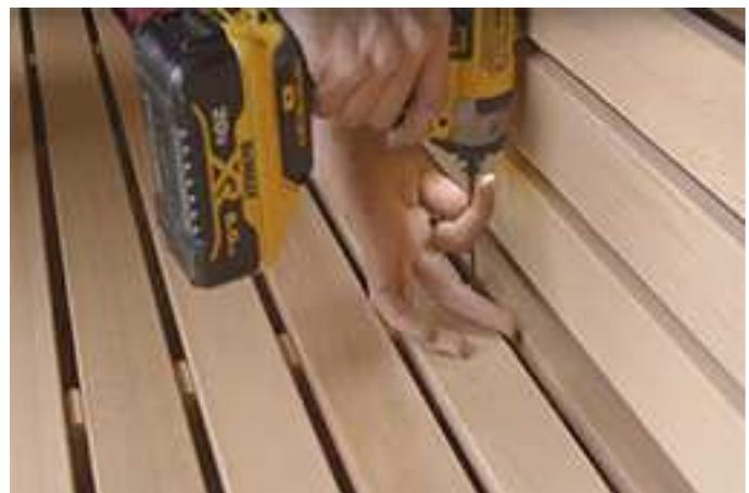
Répétez le processus pour fixer le banc inférieur au support de banc.
