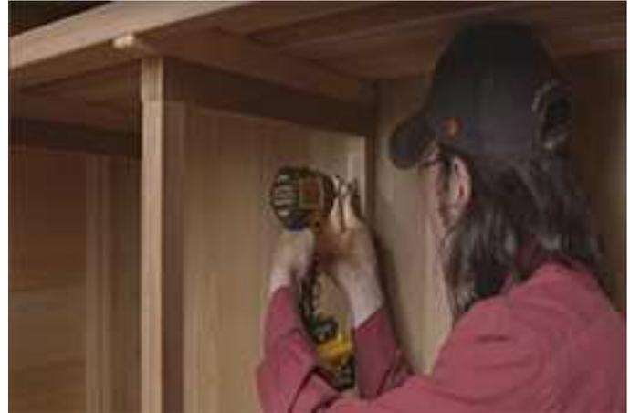
Fixez les supports de table au mur et aux supports du banc à l'aide de 2 ½ "vis.
