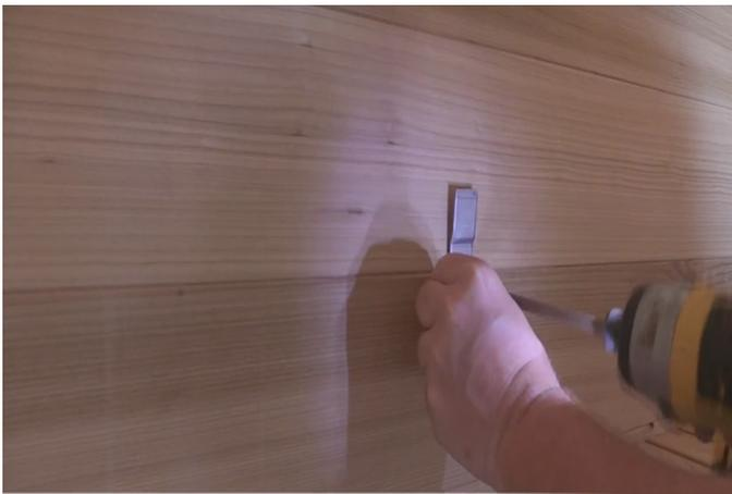
Fixez les supports de chauffage à la paroi arrière du sauna en utilisant des vis de 1 ½".
