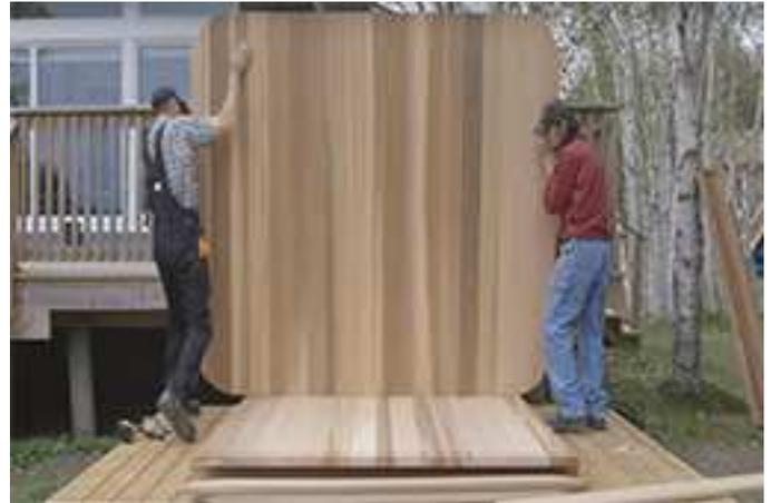
Avec de l'aide, soulevez la paroi arrière et insérez-la dans la rainure des lattes inférieures.
