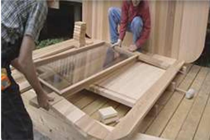
En utilisant une aide, faites glisser la fenêtre en place.
