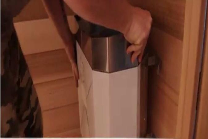
Placer l'appareil de chauffage au-dessus de la boîte dehors pour obtenir la bonne hauteur pour l'installation.
