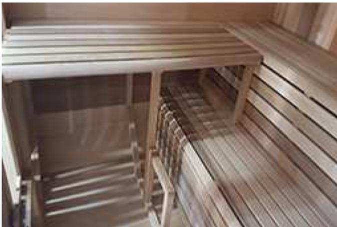
Fixez les supports du banc au dessus du banc court par le dessous en utilisant des vis de 2 ½ ".
