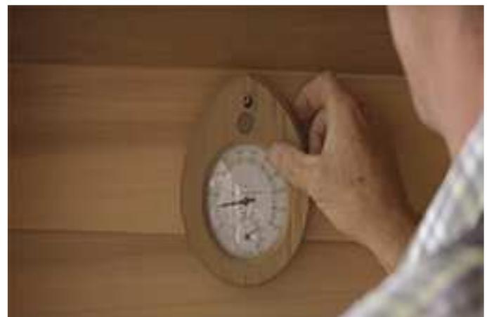
Répétez le processus avec un thermomètre en utilisant une vis de 2 "
