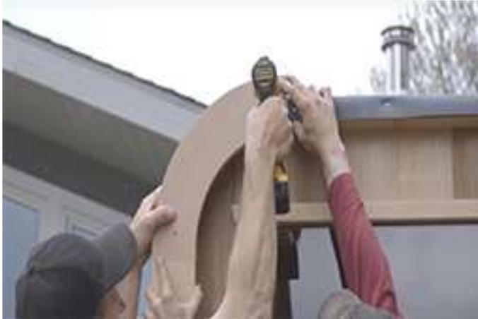
Pour éviter que les pièces de finition ne se fendent, pré-percer les pièces en premier
