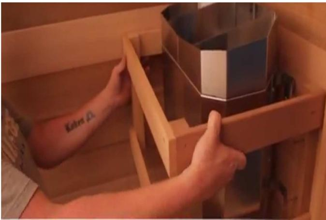
Placez la protection du radiateur autour du radiateur électrique.
