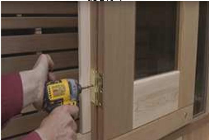
Répétez de l'autre côté à travers les trous du milieu sur les charnières supérieure et inférieure.
