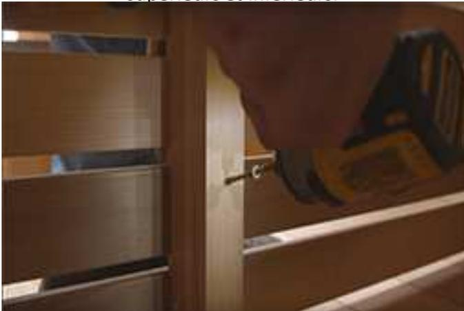
Fixez les supports de la paille aux couvercles de la paille inférieure comme indiqué en utilisant des vis de 2 ½ ".
